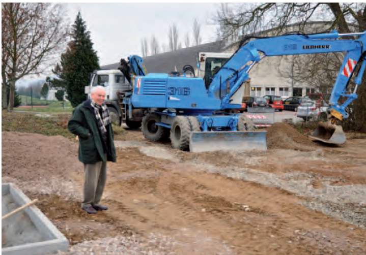
unten: Winfried Brock überwacht die Parkplatzsanierung
